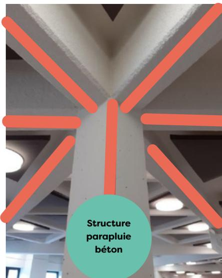
Structure parapluie béton
